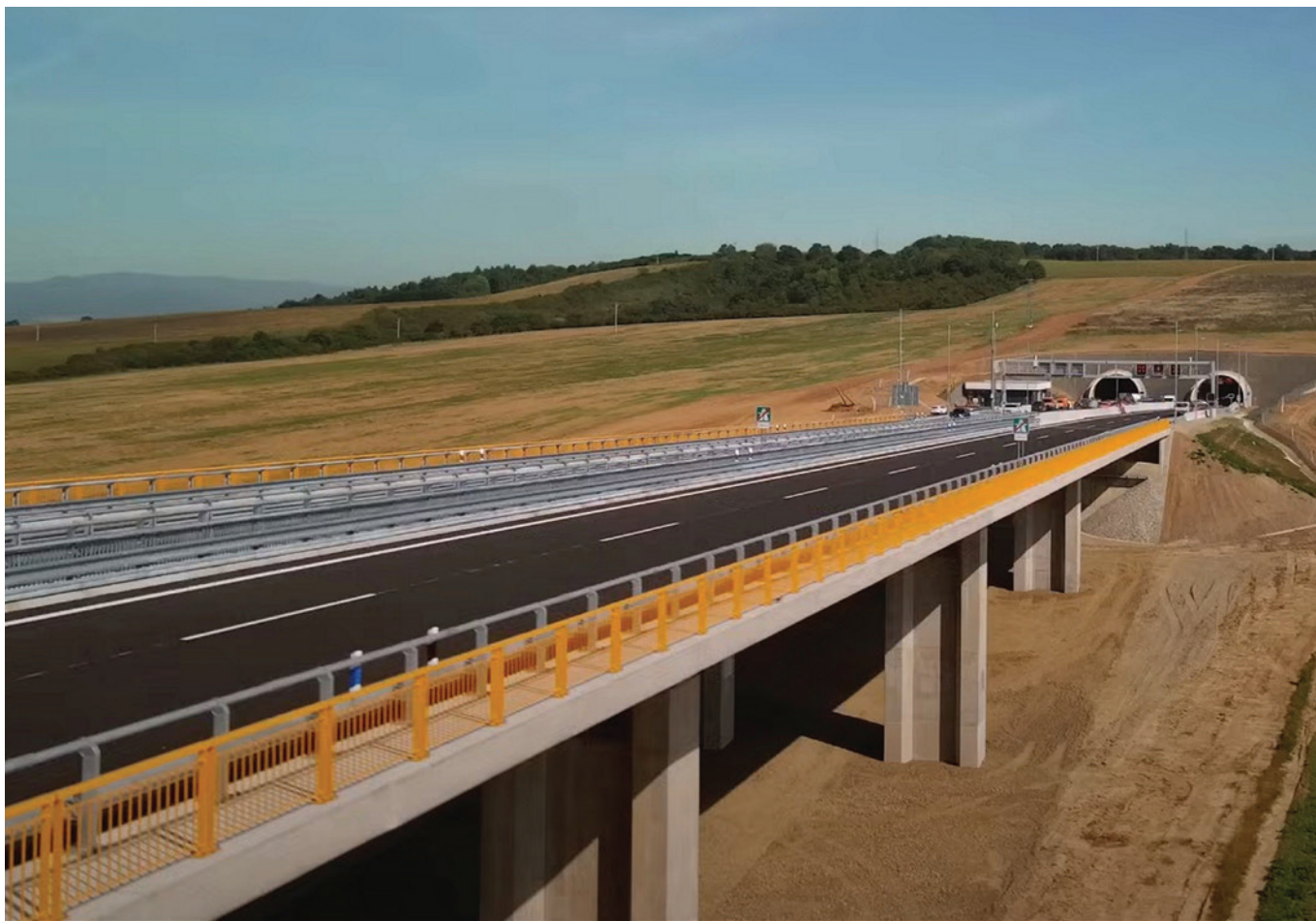
Obr. č. 1: SO 201-00 Most na R4 na km 1,35 nad údolím a poľnou cestou, v pozadí južný portál tunela Bikoš (foto: Valko)
