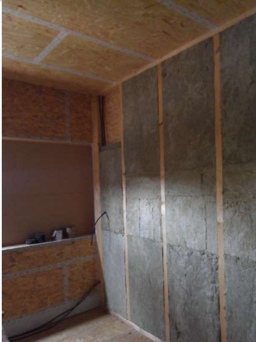
PASIVNÍ DŮM BRNO LÍŠEŇ – FOTO Z VÝSTAVBY
