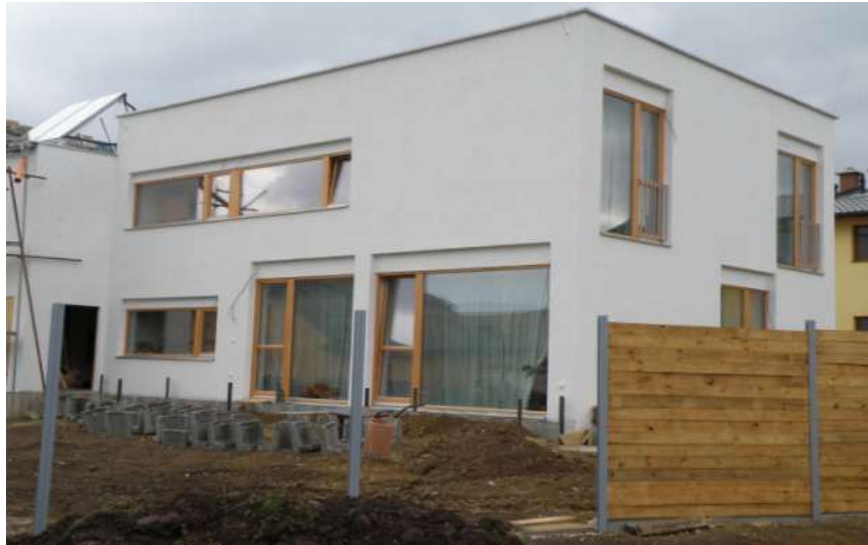
PASIVNÍ DŮM BRNO LÍŠEŇ
