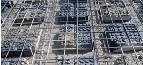
Pridanou hodnotou stropu so stratým debnením je aj ochrana životného prostredia
