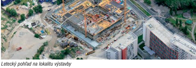
Letecký pohľad na lokalitu výstavby
