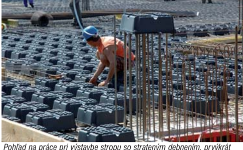
Pohľad na práce pri výstavbe stropu so stratým debnením, prvýkrát uplatnený na Slovensku
