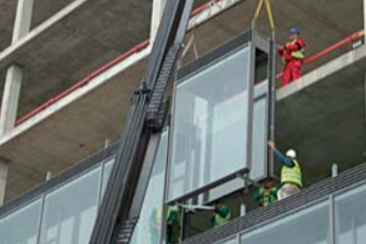
Všetky prvky boli vopred kompletne vriedené a zmontované v dielni
