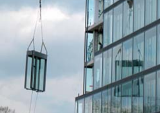
Záber na montáž posledných prvkov fasády
