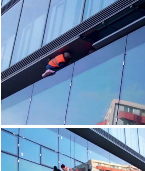
Pracovníci dokončujú montáž fasády SGG-VARIO-PR
